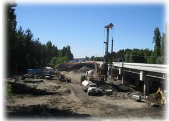
Ejecución de Pilotes Puente Ibáñez Norte, Dm. 14.100
