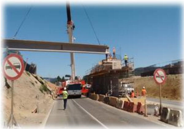
Montaje Vigas Enlace Palomares 2, Dm. 67.820
